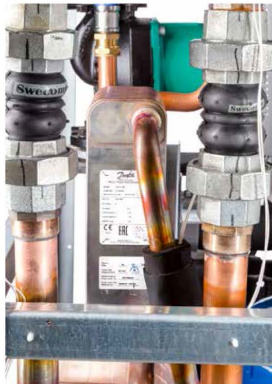
Obr. 5: Tepelné čerpadlo Mega, konfigurace jeho dílů a umístění výměník přehřátých par pro přípravu TV během vytápění.
